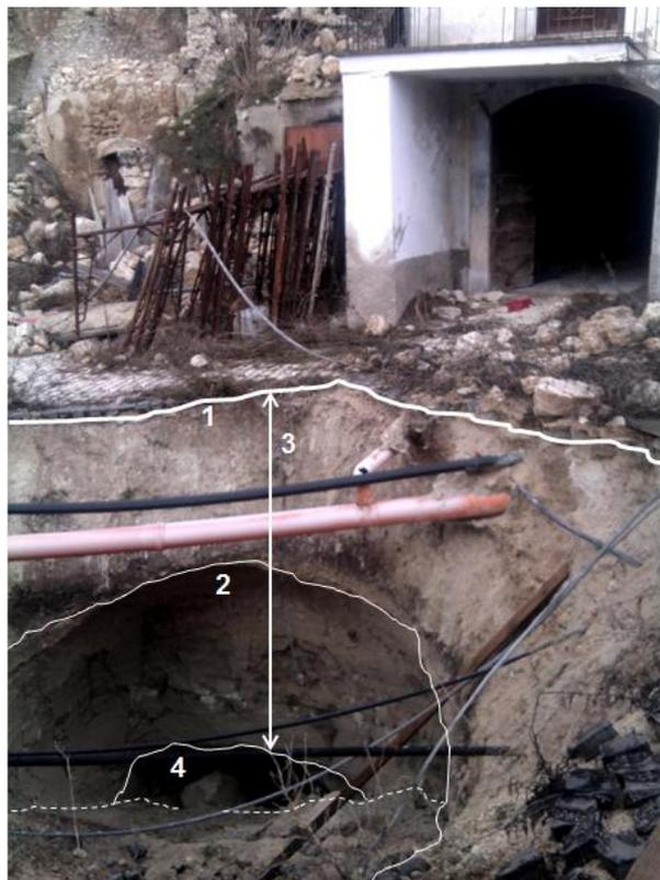
**Figura I.3.** Voragine sviluppatasi nel *borgo* a seguito dell'evento del 6 Aprile 2009, con riferimento al: il margine della voragine 1), sono distinguibili: il limite del volume di terreno sgrottato 2), lo spessore dello strato di ricoprimento 3) della sottostante cavità 4).
