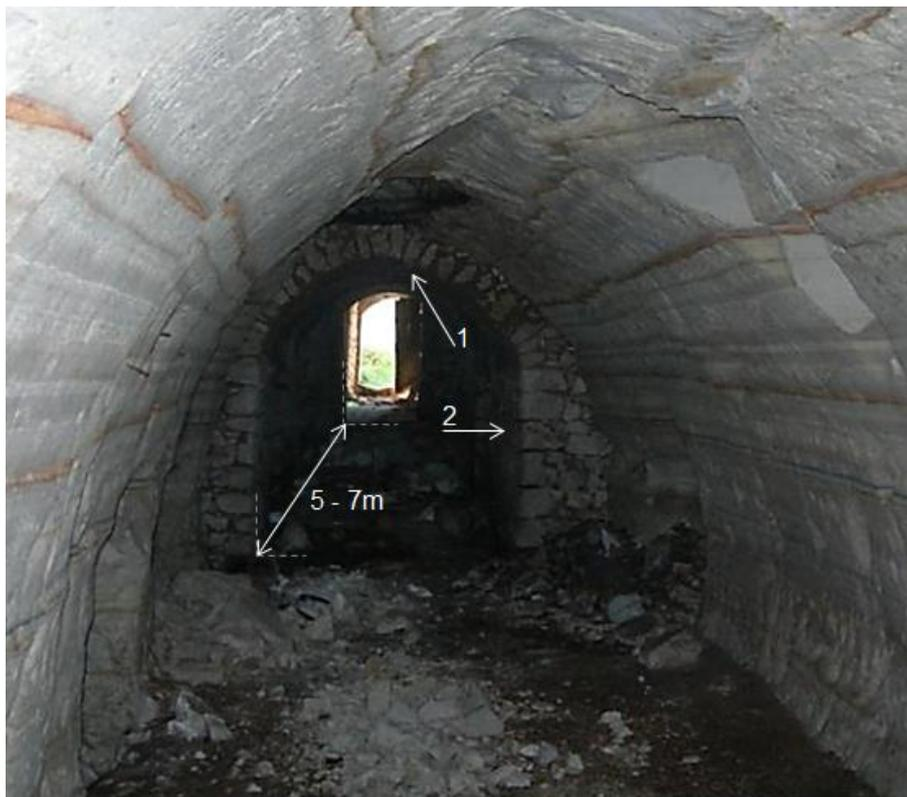
**Figura I.16.** Interno di una cavità con particolare dell'intervento di sottomurazione, con volte a botte 1) e piedritti in conci di pietra grossolanamente squadrati 2) (modificata da Borghini et al. 2010)
