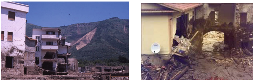
Fig. 1. Esempi di danni alle strutture, in seguito all'impatto di frane tipo flusso nei Comuni di Sarno (1998) e Cervinara (1999) (da Mavrouli et al. 2014 e Cascini et al. 2011)
