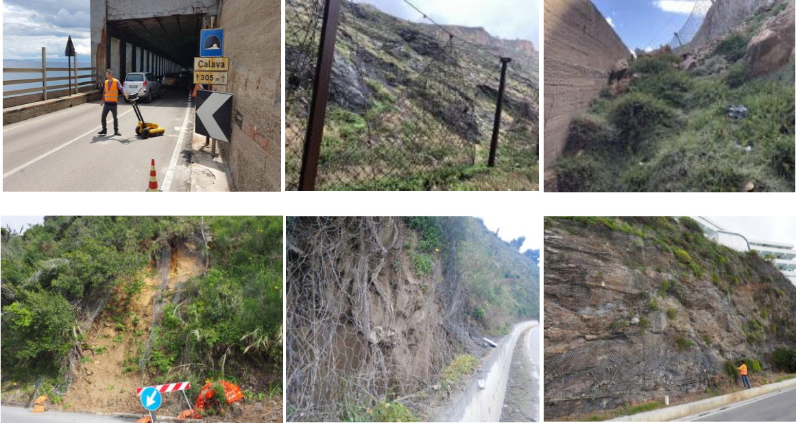
Fig. 2 Opere di difesa esistenti lungo la SS113 in evidente stato di degrado
