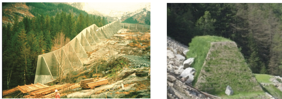
Fig. 2. Muro in calcestruzzo armato nella località Odda, Norvegia (Barbolini et al., 2009) e barriera deformabile per contenimento massi (Ronco et al., 2009).
