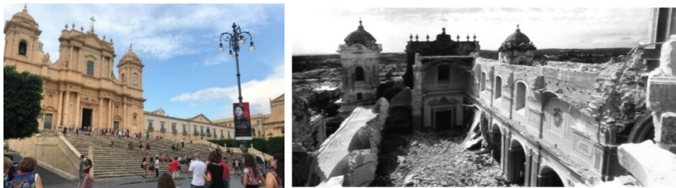
Fig 2. Cattedrale di Noto. a) Vista frontale dell'edificio; b) Configurazione interna successiva al collasso del 1996 (Di Prisco et al. 2006)
